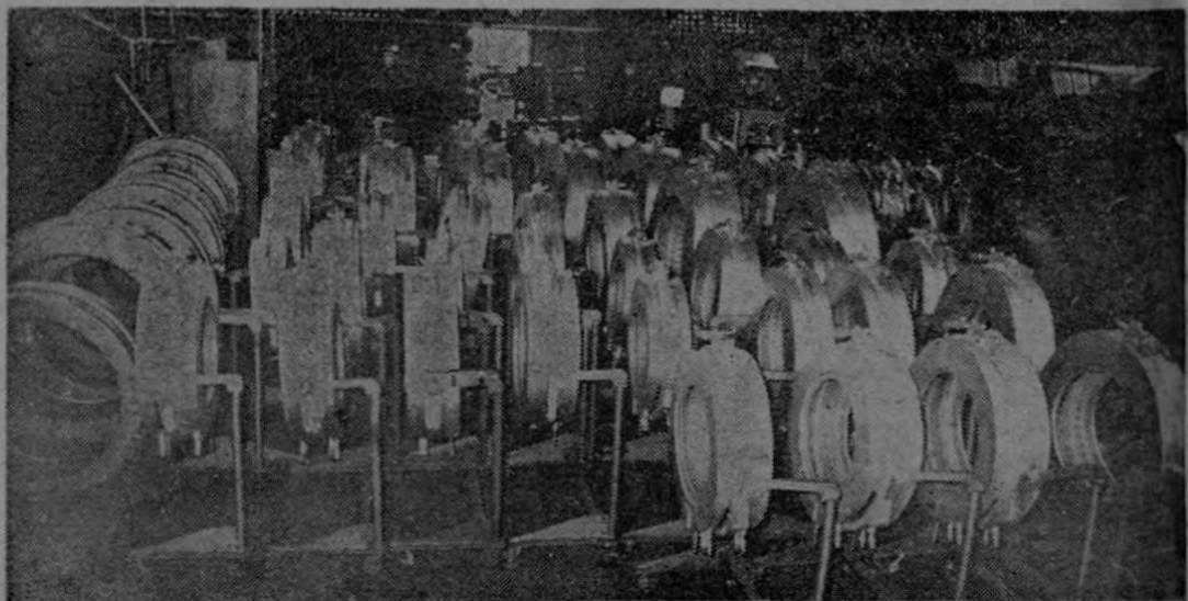
Vista panorámica de más de 40 moldes para instalar llantas de varias medidas para el proceso de vulcanización. Esperamos así poder dar cumplimiento a la enorme demanda de órdenes.
